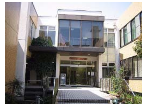
蔵本分館（改修前）
